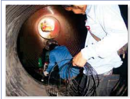
เชื่อมต่อภายนอกด้วยลวดพือิ ระบบร้อน ไม่มีการรั่วซึม
