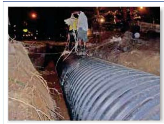
ปิดถนนไม่เกิน 2 ชั่วโมง วางท่อระบายน้ำเสร็จเรียบร้อย
