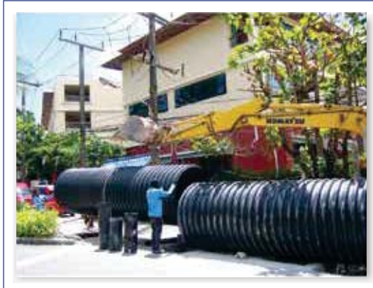
เตรียมท่อเพื่อเชื่อมต่อ (ความยาวท่อมี่ตั้งแต่ 6-15 เมตร)
