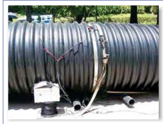
เชื่อมต่อภายนอกด้วยแผ่นพีอี เชื่อมด้วยไฟฟ้า ไม่มีการรั่วซึม
