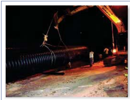
ยกวางทั้งเส้นอย่างง่ายดาย เนื่องจากท่อมี่น้ำหนักเบา
