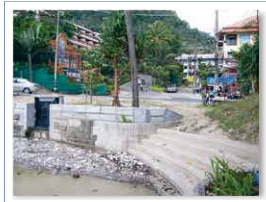
วางท่อระบายน้ำ ลงสู่ทะเลเสร็จเรียบร้อย ปลายท่อมี่ประตูเปิด - ปิด กันน้ำทะเลไหลเข้าเมื่อน้ำขม
